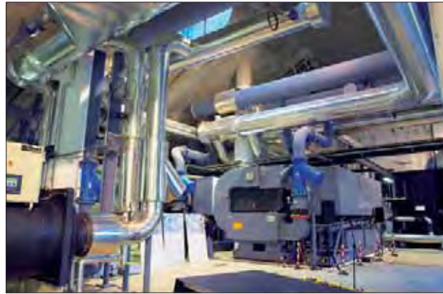
Figura 32.2. Planta de generación de frío.
