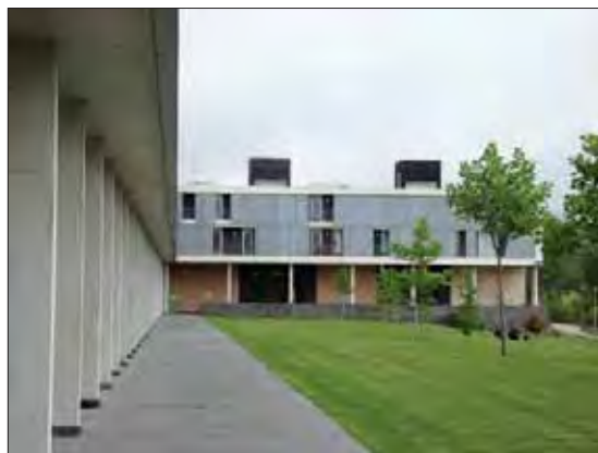
Figura 3.4. Ecociudad de Sarriguren, fachada sur, protección solar móvil.
