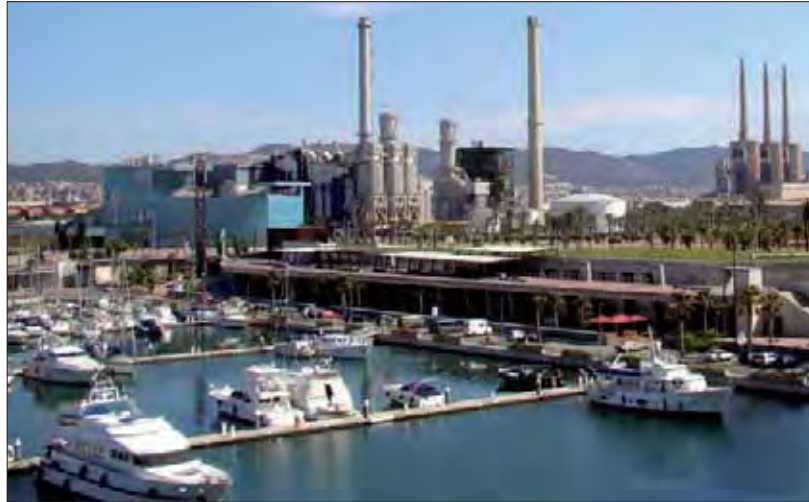
Figura 32.5. Vista exterior de la planta de tratamiento de residuos sólidos urbanos.
