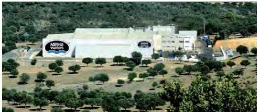
Figura 21.1. Vista aérea de la fábrica.
