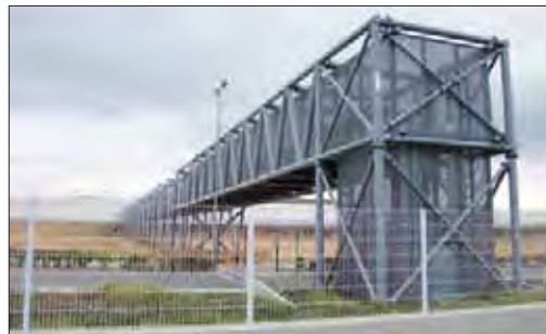
Figura 31.5. Vista de la red de distribución en forma de rack aéreo.
