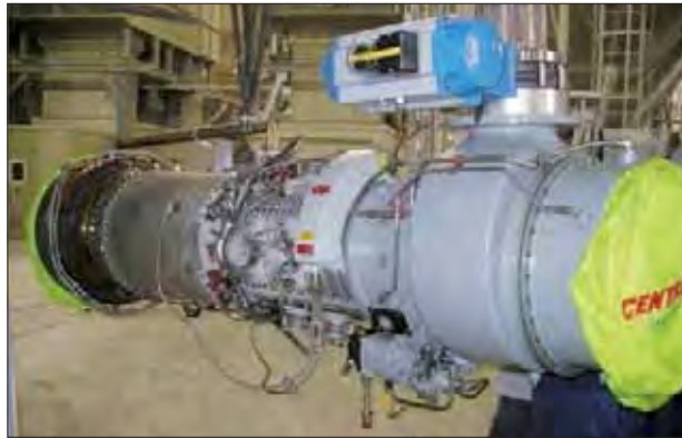
Figura 26.4. Turbina en proceso de montaje en el circuito de cogeneración.
