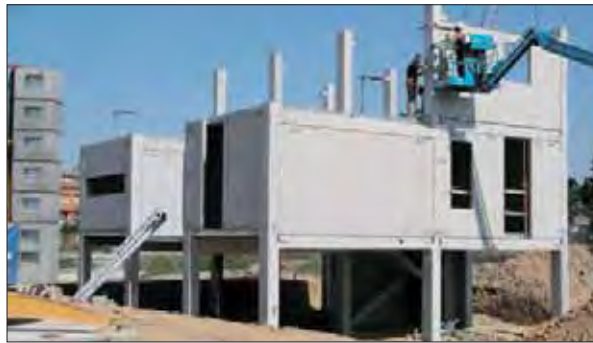
Figura 1.2. Casa Kyoto - sistema de construcción prefabricada.
