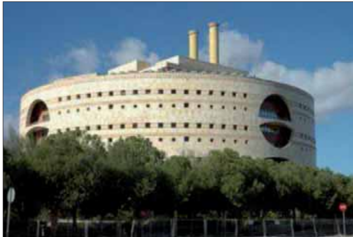
Figura 8.1. Edificio auditado por la Red de Energía.
