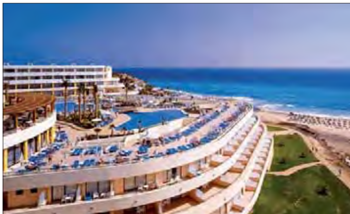
Figura 13.2. Vista aérea del Hotel Playa Gaviotas.
