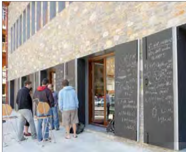
Figura 7.6. Detalle de la fachada. Fuente: CCBPP.
