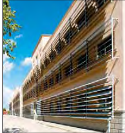
Figura 15.5. Lamas de protección solar.
