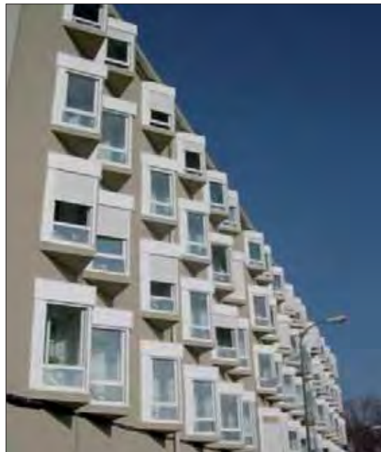
Figura 2.1. Bloque rehabilitado. Fachada Este.
