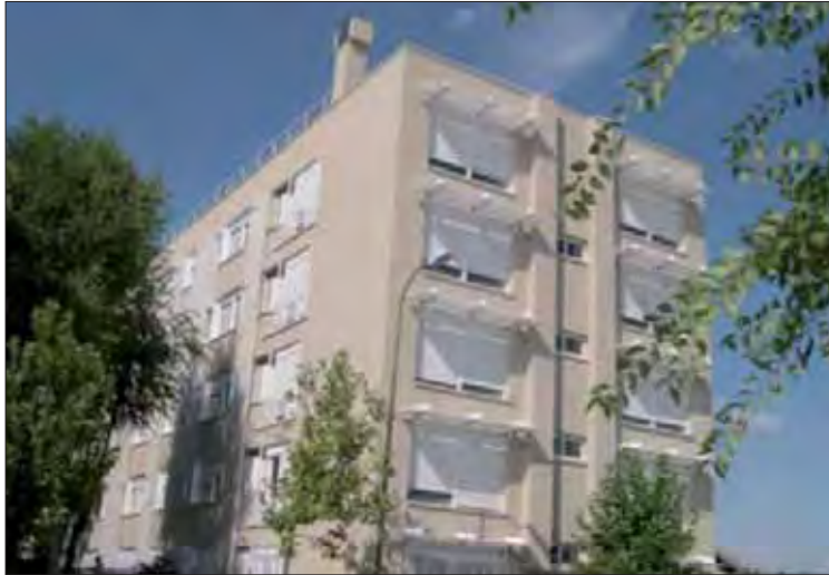
Figura 2.2. Bloque nuevo. Fachada Sur.
