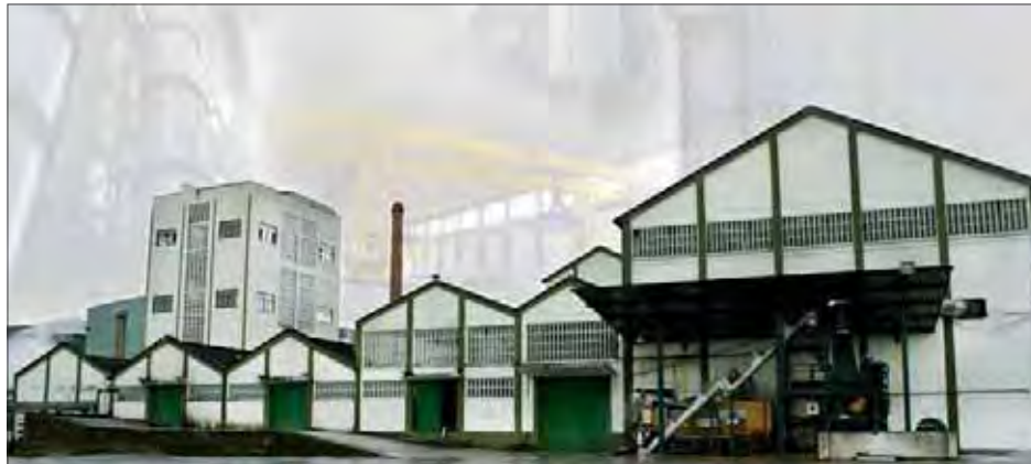
Figura 19.1. Vista general de la fábrica.
