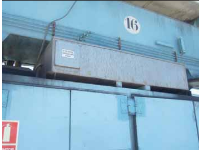
Figura 28.4. Batería de condensadores en prototipo de grúa Eco-RTG.
