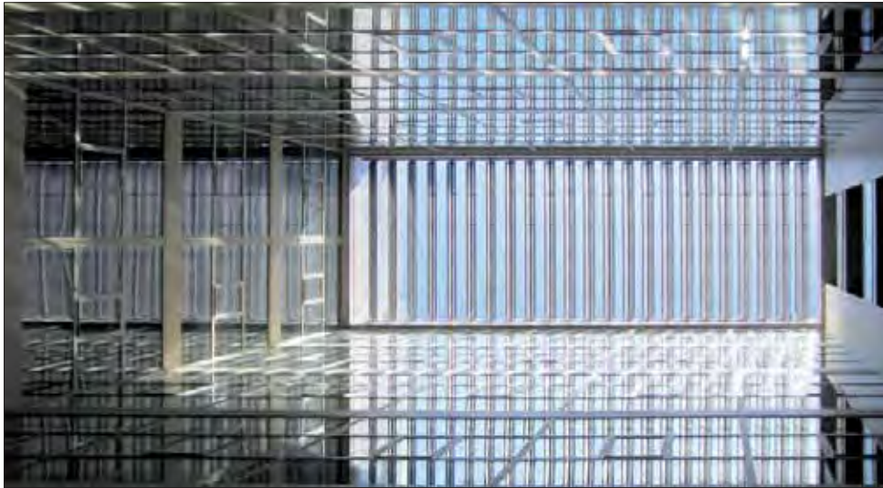
Figura 12.3. Protección solar del atrio. Fuente: Gallardo-Bravo Arquitectos S.L.P.
