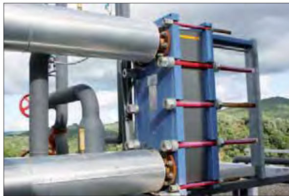
Figura 20.4. Intercambiadores de calor.
