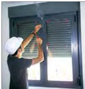
Figura 3.10. Prueba de fugas de aire.
