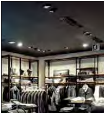
Figura 10.3. Rejillas de distribución de aire de climatización.
