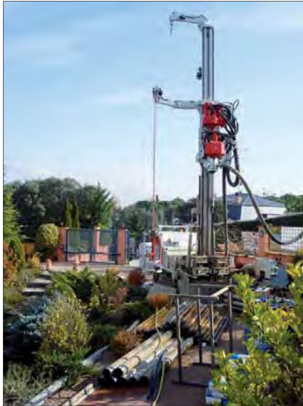
Figura 4.4. Perforación de pozos geotérmicos.
