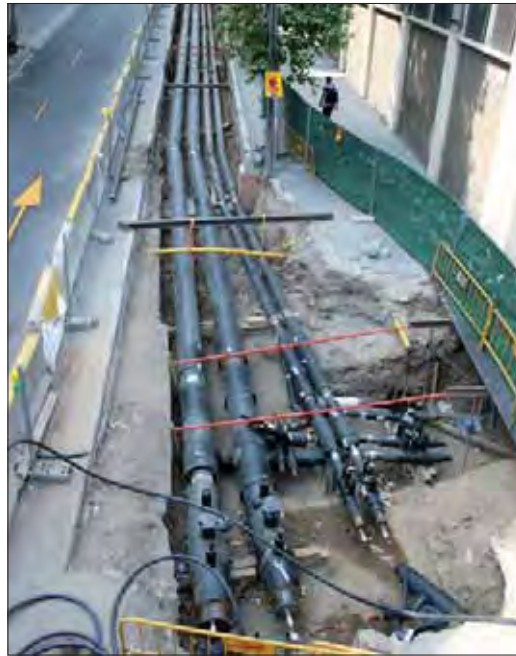
Figura 32.3. Montaje tuberías preaisladas.
