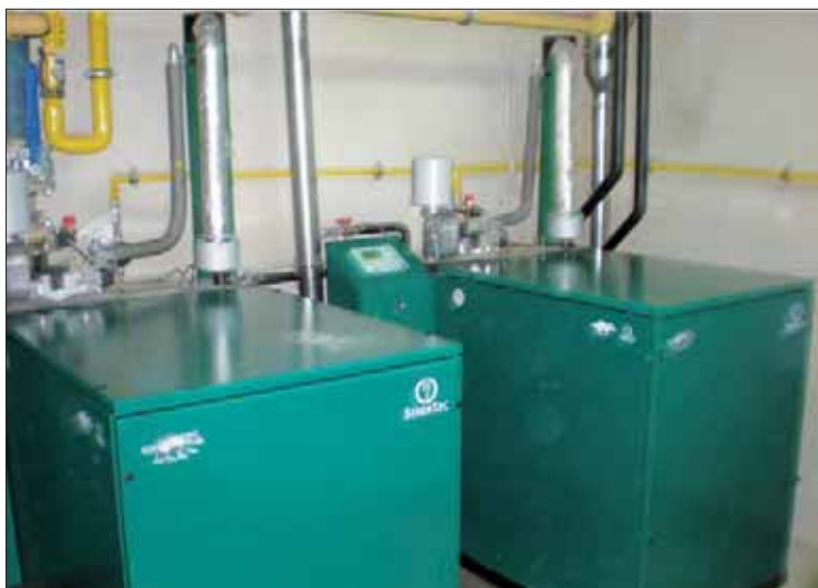
Figura 14.4. Unidades de microgeneración.
