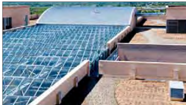
Figura 15.6. Cubierta tipo aljibe.
